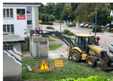
Démolition anciennes toilettes publiques
