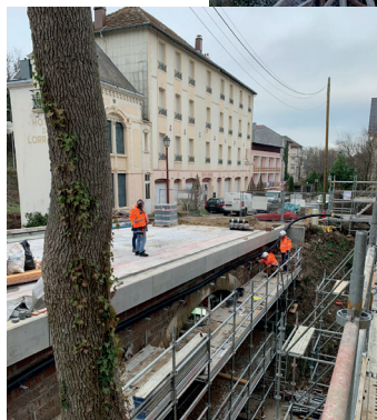
Démolition et reprise du tablier du pont de la gare
