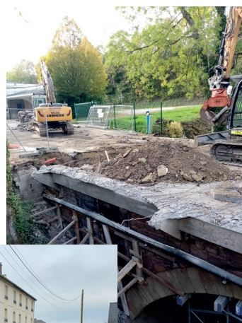
Démolition et reprise du tablier du pont de la gare
