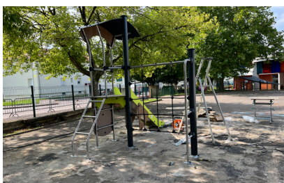
Remplacement structures de jeux - cour école maternelle
